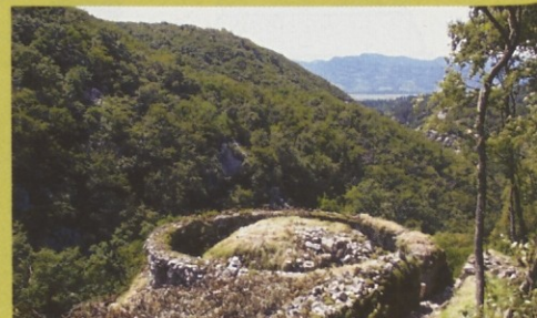
Del avstro-ogrskih utrd na Gradišču.
