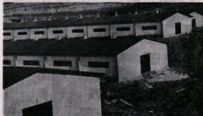
Dokončani objekti Perutninarske farme v Hanjskem
