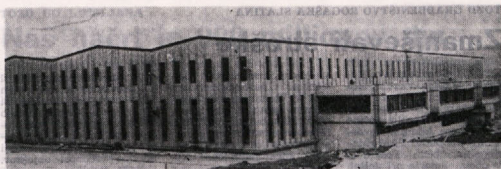
EMO — tovarna energetske opreme v Sentjurju — zgrajena po montažnem sistemu
