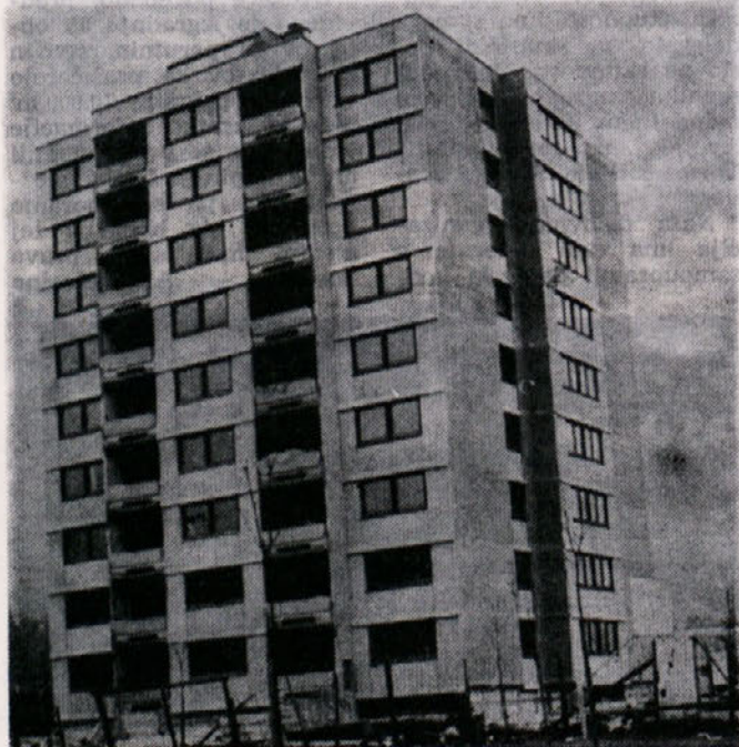
Stanovanjska stolpnica v Štoreh
