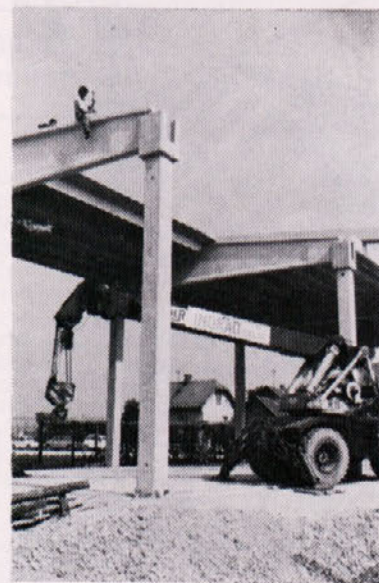
Montažna dela na objektu
