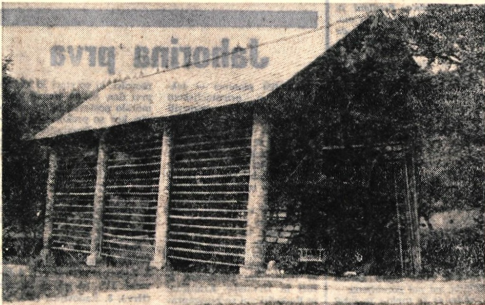
Dvojni kozolec (toplar) na z obio opeko zidanih okroglih stebreh — edinstvena gradbena posebnost stoji ob Jeralovi domačiji v Njivici ob cesti proti Nemiljam.
