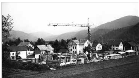
Gradnja nove šole, v ozadju (poleg žerjava) stoji stara šolska stavba. Foto: arhiv TD Selca
