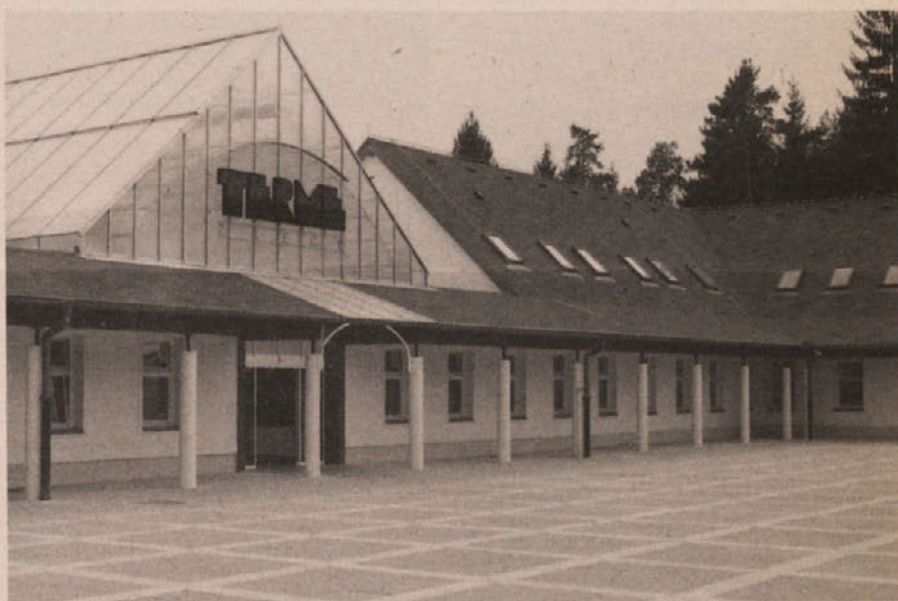
Terme Zreče, sklop objektov novega zdravilišča in zdravstvene postaje zajema dobrih 3000 m 2 površine pokriti bazenski del, trakt terapije in servisne prostore. Zunanji bazen s ca. 800 m 2 vodne površine je povezan z notranjim.
