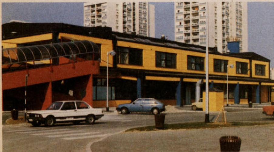
Tržni center je središče dogajanja v zagrebški občini Dubrava. Trietažni objekt so delavci GO Celja zgradili z montažnim sistemom Ingrad. Foto Vili Šuster
