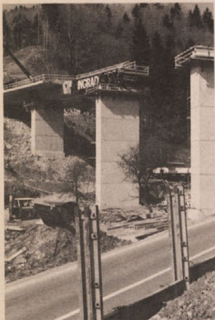
Tehnično najbolj zahtevno gradnjo smo izvajali letos na viaduktu Baba. GO Celje
