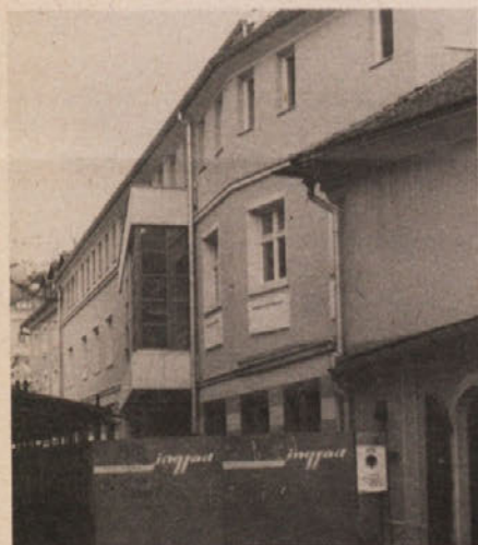
Poslovno stanovanjski objekt v središču Celja bomo dokončali še letos.
