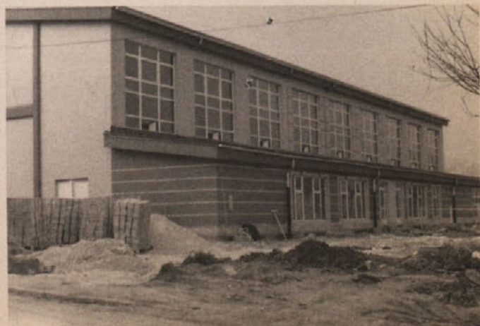
Zaključujemo z gradnjo telovadnice v Slov. Konjicah
