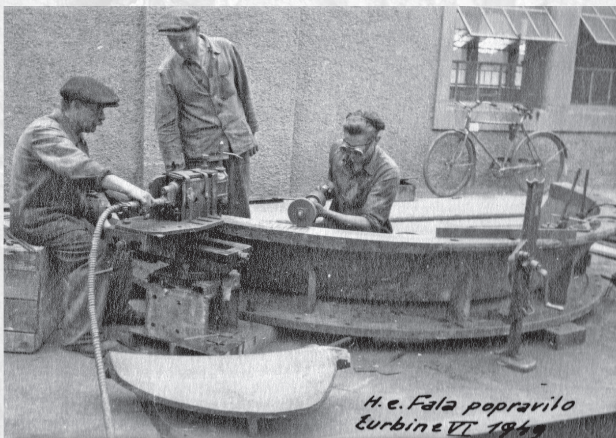
Popravilo turbine v hidroelektrarni Fala, fotografija, 1949 (PAM, fond Dravske Elektrarne Maribor, Hidroelektrarna Fala, AŠ 14)
