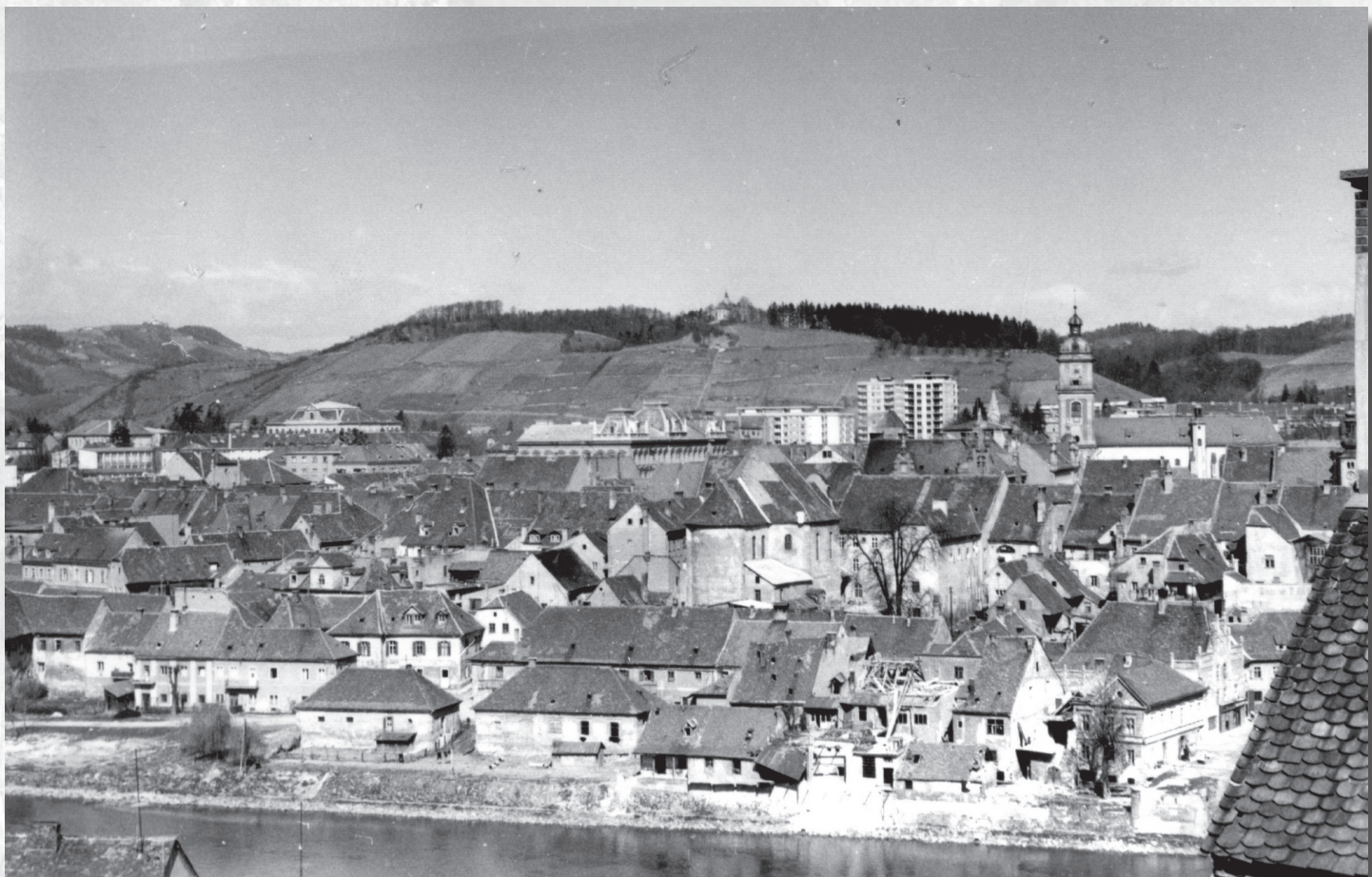
Začetek rušenja hiš v mariborskem Pristanu, 9. 3. 1967 (PAM, fond Zavod za urbanizem Maribor, TE /Vojašniška ulica)
