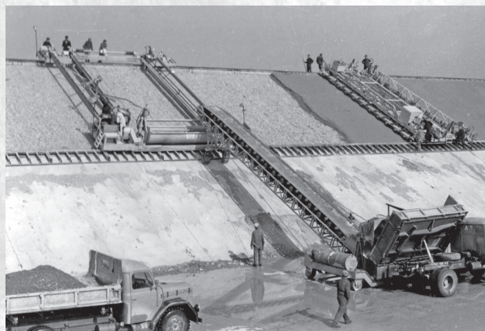
Polaganje betonske obloge v dovodnem kanalu, fotografija, 18. 3. 1968 (PAM, fond Tehnogradnje Maribor, AŠ 598)
