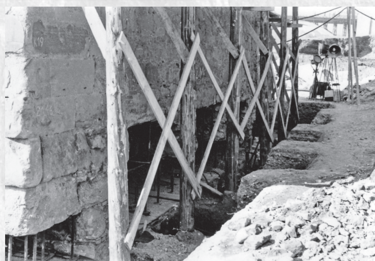
Dvig Vodnega stolpa v Mariboru, fotografije (PAM, fond Zavod za urbanizem Maribor, TE 52/ Usnjarska ulica)
