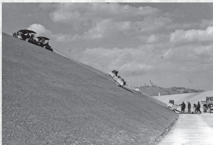
Gradnja dovodnega kanala in v ozadju Malečnik pri Mariboru, fotografija, 18. 3. 1968 (PAM, fond Tehnogradnje Maribor, AŠ 598)
