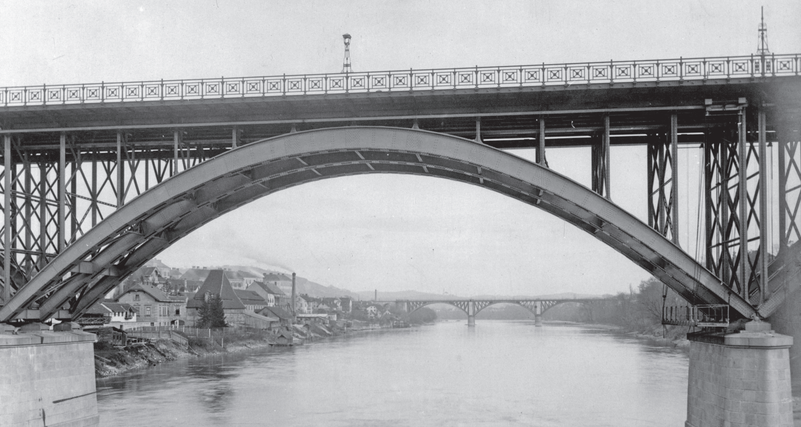
Zgoraj: Pogled proti Vodnemu stolpu pod loki novega Glavnega mostu, fotografija, 1913 (PAM, Zbirka albumov fotografij in razglednic, AŠ 16)
