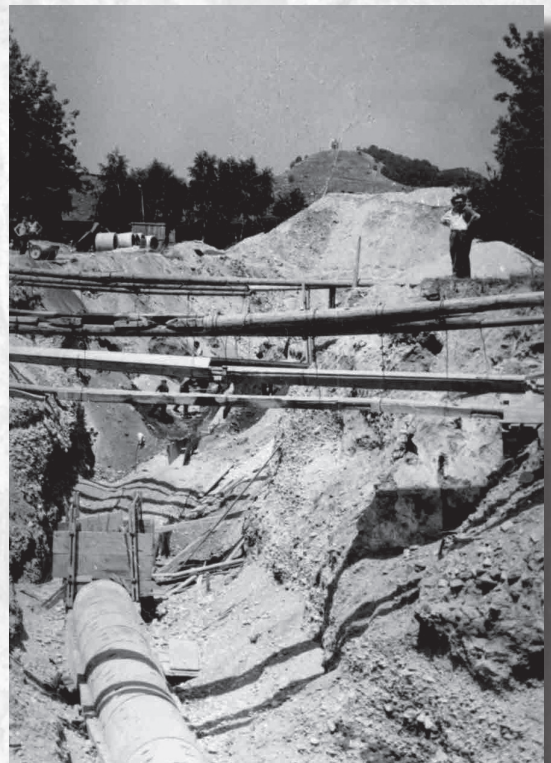
Zemeljska dela (polaganje novega kolektorja) na Oreškem nabrežju v Mariboru, fotografije, 1967 (PAM, fond Zavod za urbanizem Maribor, TE 12/83)
