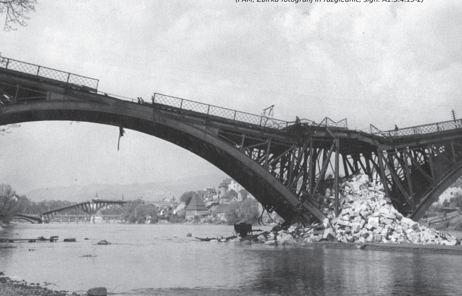
Spodaj: Minirana železniški in glavni most in pogled proti Vodnemu stolpu, fotografija, 7. 4. 1941 (PAM, Zbirka fotografij in razglednic, sign. A1.3.4.15-2)
