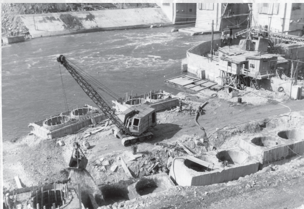
Gradnja hidroelektrarne Ožbalt, fotografije, 30. 7. 1959–13. 3. 1961 (PAM, fond Cestno podjetje Maribor, AŠ 534/44)
