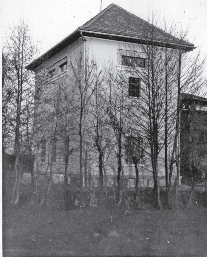
Nova transf. postaja Ljutomer I 1946 35 kV
