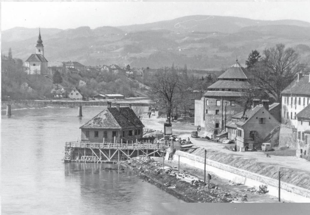
Gradnja zaščitnega zidu pri hiši Mariborske Benetke in v ozadju Sodni stolp, studenška brv ter cerkev sv. Jožefa na Studencih, fotografija, 3. 4. 1968
