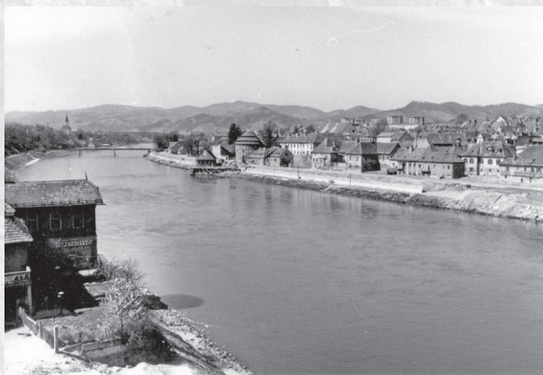
Gradnja zaščitnega zidu pri hiši Mariborske Benetke in pogled na Lent, fotografija, 3. 4. 1968 (PAM, fond Splošno gradbeno podjetje Konstruktor Maribor, AŠ 89)
