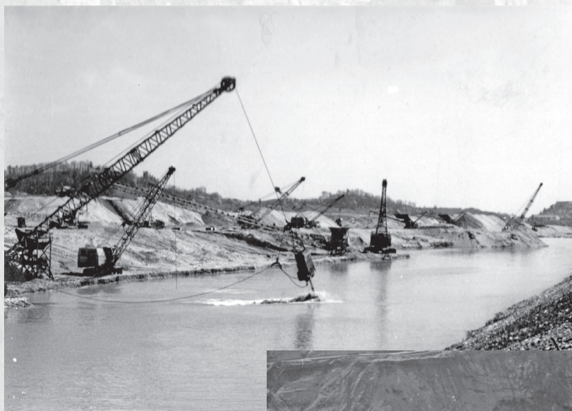
Gradnja odvodnega kanal pred Ptujem, fotografija, 14. 4. 1966 (PAM, fond Tehnogradnje Maribor, AŠ 598)
