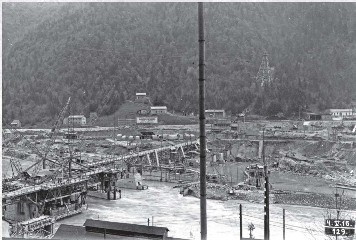
Gradnja hidroelektrarne Fala, fotografija, 4. 5. 1916 (PAM, fond Dravske Elektrarne Maribor, Hidroelektrarna Fala, AŠ 60)
