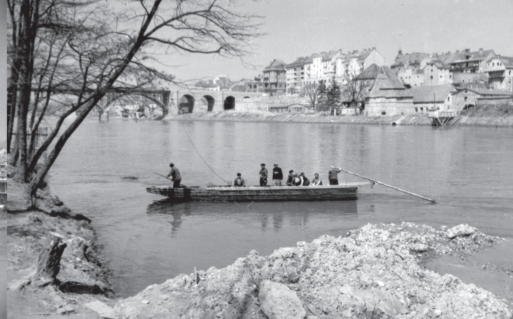
Pogled proti Vodnemu stolpu ob začetku gradnje Titovega mostu, fotografija, 21. 4. 1962 (PAM, fond Zavod za urbanizem Maribor, TE 14-11)
