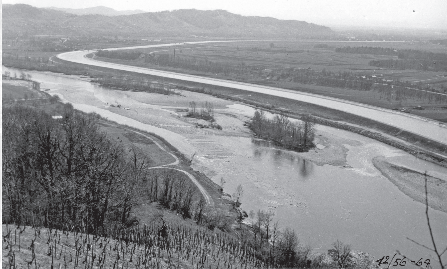
Pogled z Meljskega hriba pri Mariboru na strugo Drave in dovodni kanal hidroelektrarne Zlatoličje, fotografija, 1969 (PAM, fond Zavod za urbanizem Maribor, TE 47/115)
