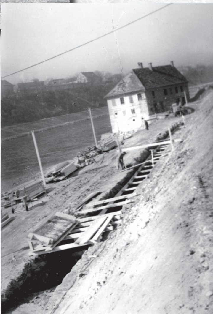
Gradnja temeljev obrežnega zidu v Pristanu in hiša Mariborske Benetke v ozadju, fotografija, 1968 (PAM, fond Zavod za urbanizem Maribor, TE 50/Pristan)
