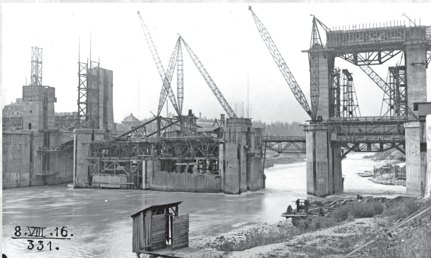
Gradnja hidroelektrarne Fala, fotografija, 8. 8. 1916 (PAM, fond Dravske Elektrarne Maribor, Hidroelektrarna Fala, AŠ 60)
