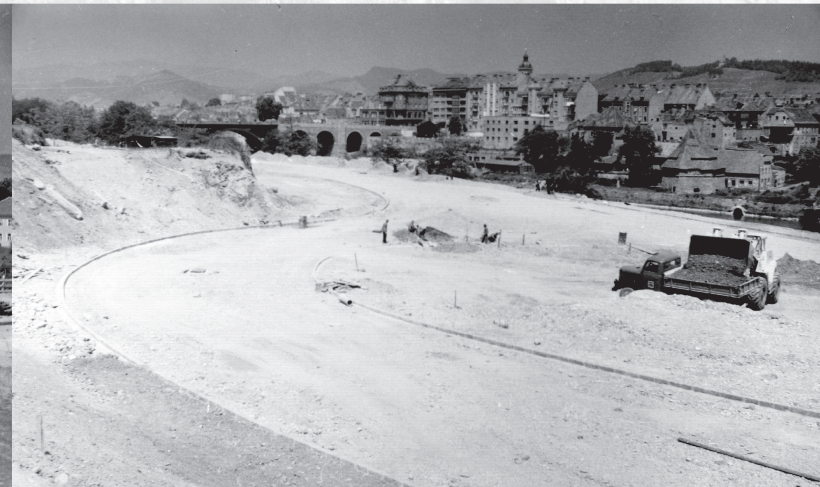
Gradnja nove Pobreške ceste in v ozadju Vodni stolp, fotografija, 11. 6. 1964 (PAM, fond Zavod za urbanizem Maribor, TE 14-102)
