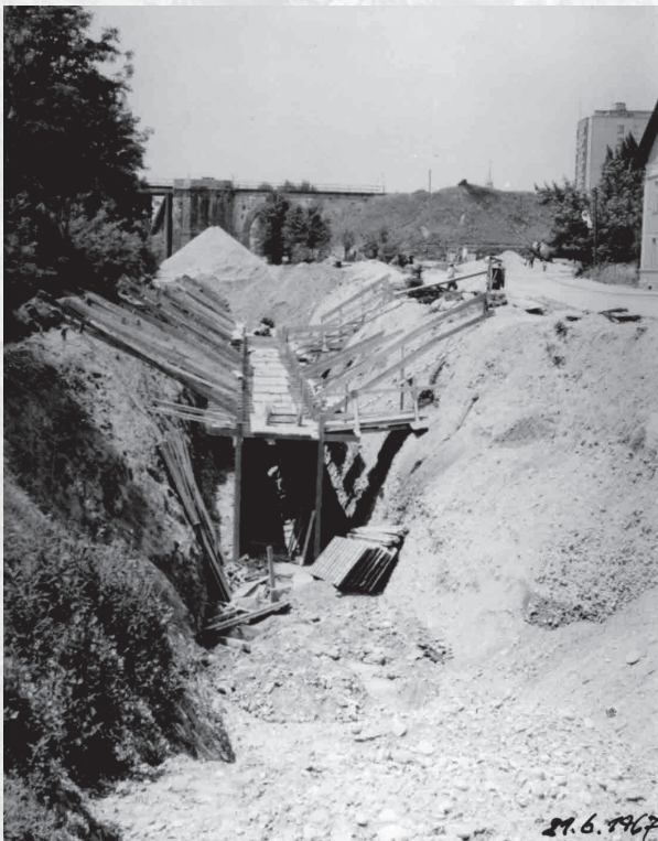
Zemeljska dela (polaganje novega kolektorja) na Oreškem nabrežju v Mariboru, fotografije, 1967 (PAM, fond Zavod za urbanizem Maribor, TE 12/83)
