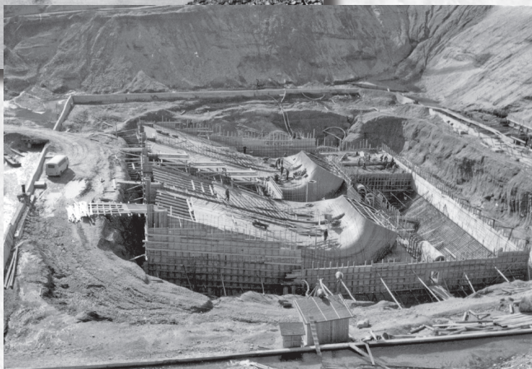
Gradbena jama in začetek gradnje strojnice v Zlatoličju, fotografija, 22. 3. 1966 (PAM, fond Tehnogradnje Maribor, AŠ 598)
