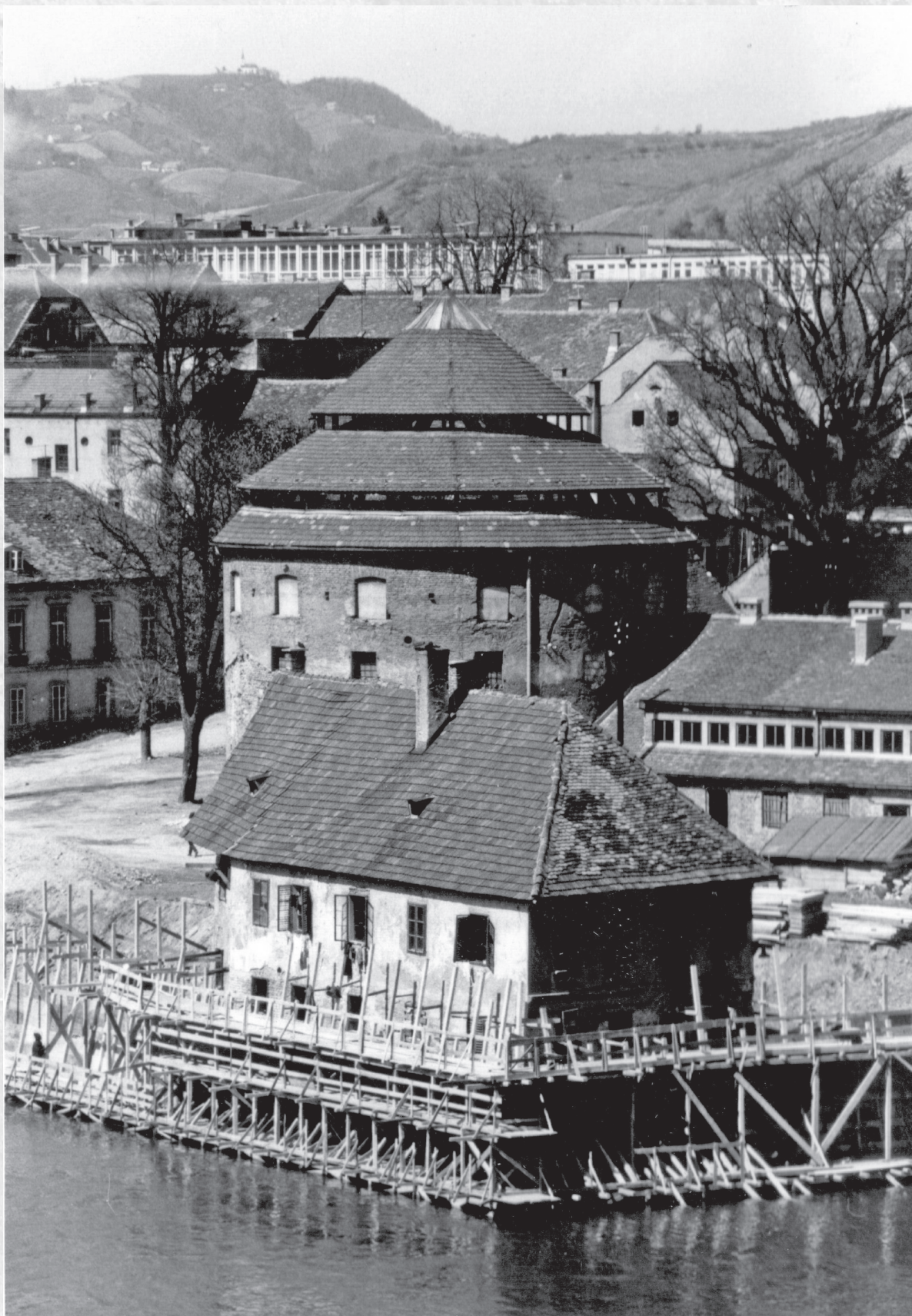
Maribor, gradnja zaščitnega zidu pri hiši Mariborske Benetke in Sodni stolp v ozadju, fotografija, 3. 4. 1968
