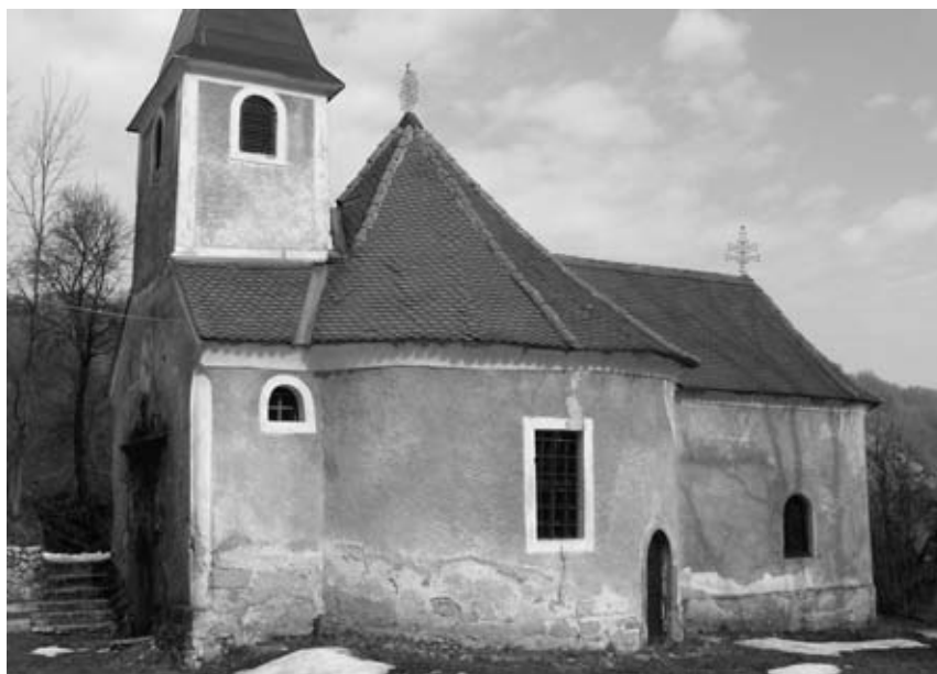
9. Kapela Ranjenog Krista u Kostelu, pročelje
