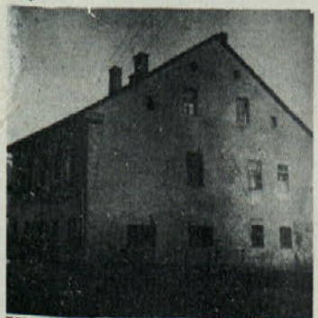
Ključavničarska delavnica od 1946–1953
