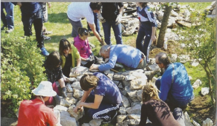
Gradnja Male hiške v Lokvi. - Fotografija: Borut Juvanec.
