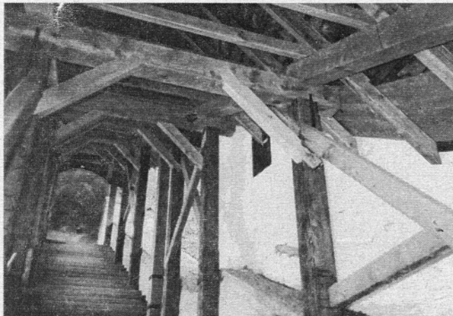
Pogled pod ostrežje stopnišča (foto: F. Kotnik)
