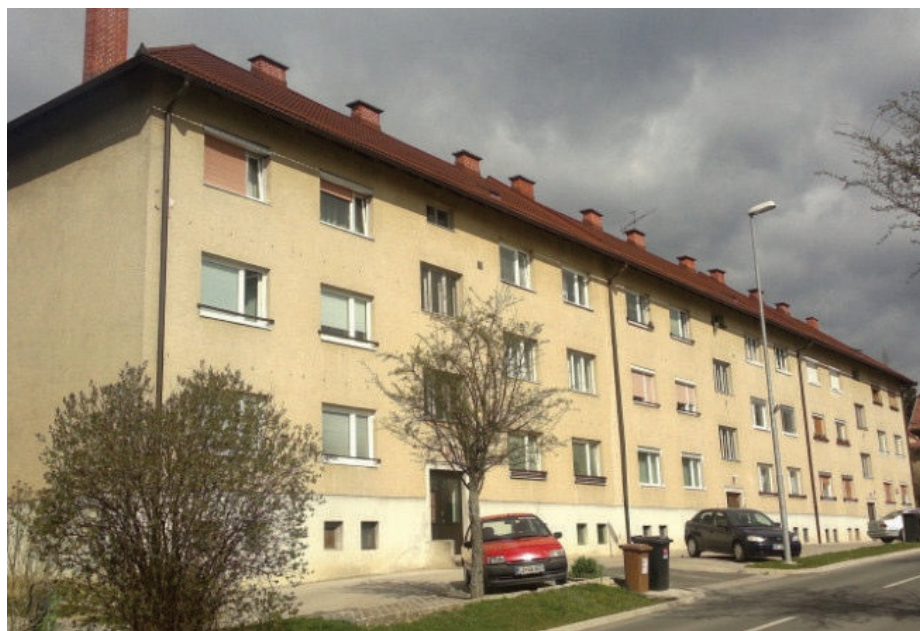
Slika 2 • Večstanovanjska stavba A.
