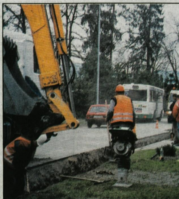
Zadnjič pa smo fotografirali tudi delavce, ki so asfaltirali ob Pelechovih cesti med Radomljami in Preserjami. Na pristojnem oddelku smo izvedeli, da je bila preplastitev cestišča nujno potrebna.
