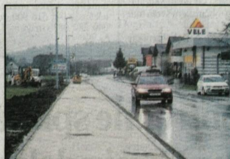
Gradnja hodnika za pešce ter kolesarske steze na Bukovčevi cesti na Viru je končana. Investicija, vredna 6 mio SIT, zagotavlja bistveno večjo prometno varnost ob zelo prometni cesti.
