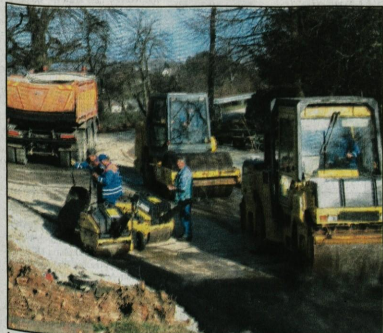
Lepo vreme v prvih aprilskih dneh je izvajalcem del na odseku Sv. Trojica-Konfin omogočilo, da so dokončali dela. Tako se lahko sedaj brez strahu pred blatom in lužami odpravimo še nekaj sto metrov dalje - v prebujajočo se naravo.
