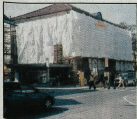
Kar nekaj časa pa bo treba še počakati, da bomo videli, kakšna bo obnovljena fasada občinske stavbe.
