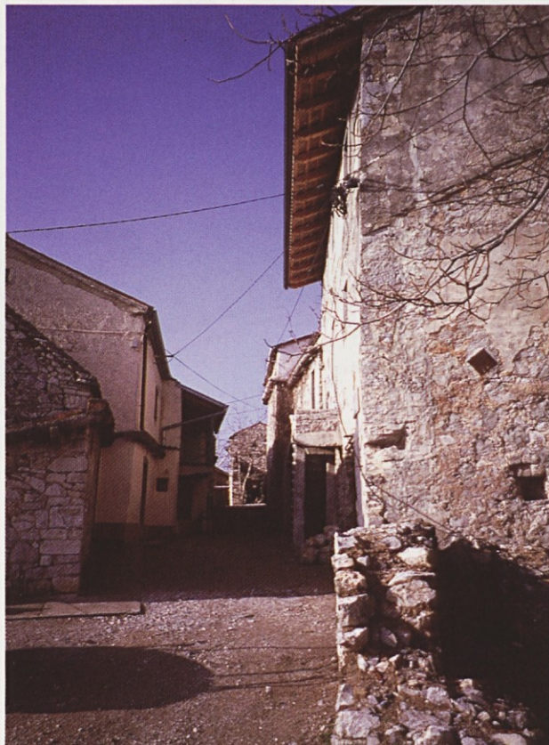
Pogled na ulico, ki čaka na obnovo.
