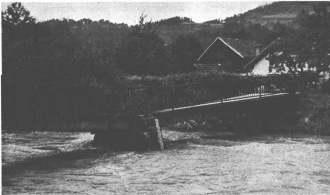
Poškodovani most v Smartnem
