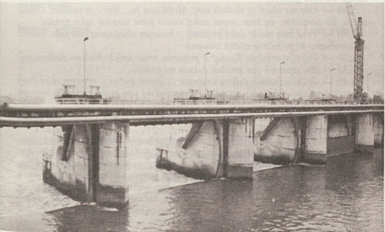
Betonske zapornice, ki regulirajo nivo Save pri Krškem
