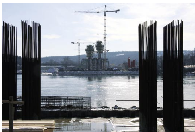
Razdalja med stebrom 5 (armatura v ospredju) in podporo 6 (pilon v ozadju) predstavlja glavni razpon dolžine 376 m
