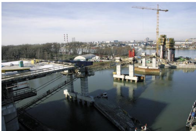
Narivanje prekladne konstrukcije preko začasnih podpor v zadnjem 200 m razponu (feb 2010)
