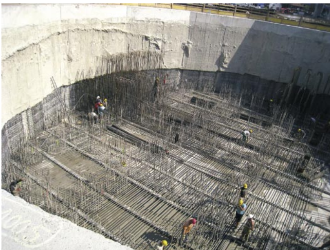
Začetek polaganja armature za pilotno plazino temelja pilona premera 36 m (avgust 2009)
