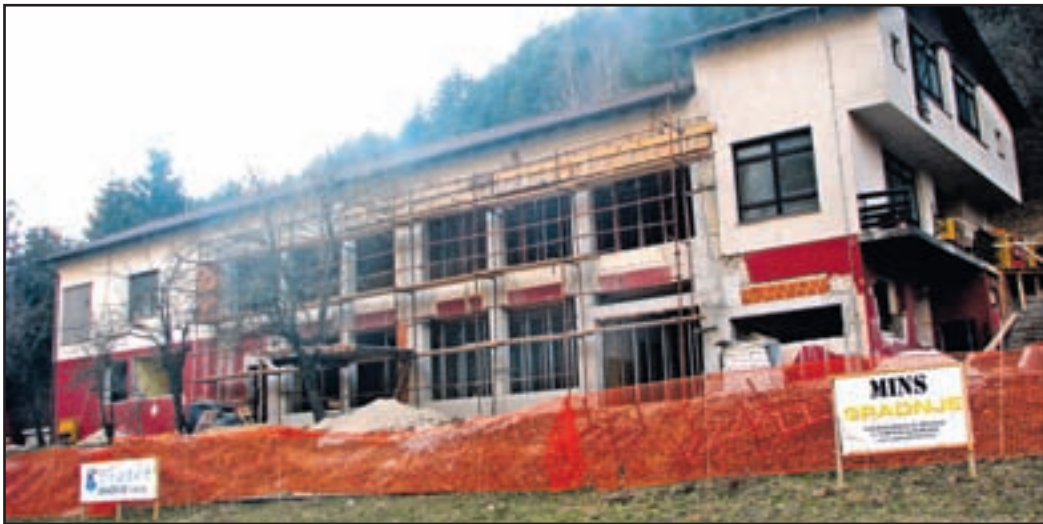
Prenova nekdanje šole dobro napreduje. Spodnji del zgradbe bo nov dom krajanov Paka in ti ga res že težko čakajo.
