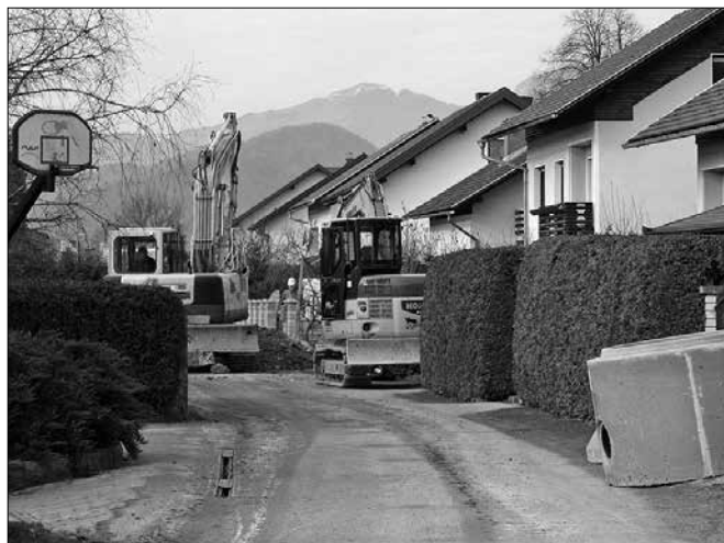
Dela na izkopu sekundarnega voda v Nizki (foto: Marija Lebar)
