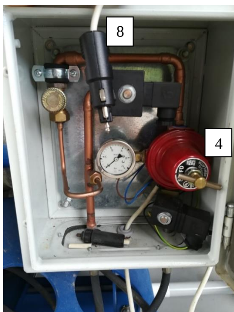
Slika 66: Omarica z ventilom za regulacijo pretoka plina (levo; 4 - Ventil za regulacijo pretoka plina, 8 - Napajalni kabel), upravljalnik za vklop plamena (desno)
