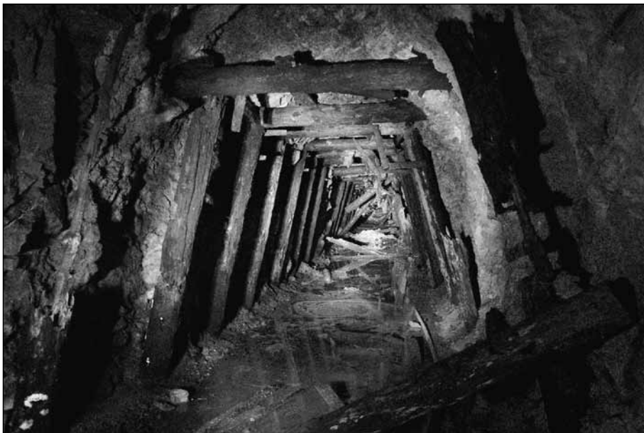
Značilna trapezasta podpora tesarba v rudnikih 19. stoletja, tu primer rudnika svinčeve rude pri Veliki Pirešici nad Žalcem v Savinjski dolini, na nadmorski višini 489 m. Obratoval naj bi do 1886. Foto: G. Schmidt, stanje 2011; objekt Šta-Velika Pirešica Pb-Spodnji Kotnik-(Barbara).
