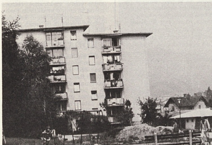
V dveh starejših zgradbah, prvih z lastnim centralnim ogrevanjem v tem delu Litije, stanovalci nimajo izbire za ogrevanje, ker nimajo dimnikov. (Na srehi vidimo le dva zračnika — slika zgoraj.) V teh blokih so pred
