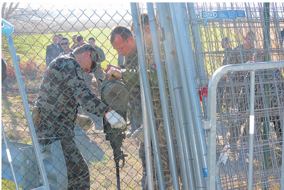
V Središču ob Dravi so v četrtek zjutraj začeli postavljati prve metre ograje.
