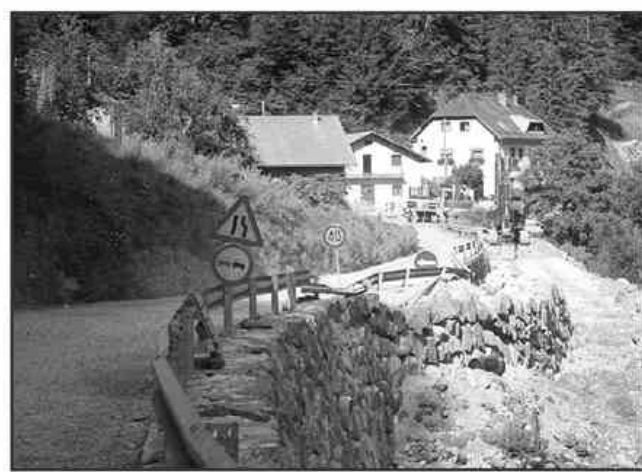
Ob lastnih naporih in dosežkih so v občini Luče zadovoljni tudi z nadaljevanjem gradnje ceste med Ljubnim in Lučami, trenutno stroji brnijo v Strugah
