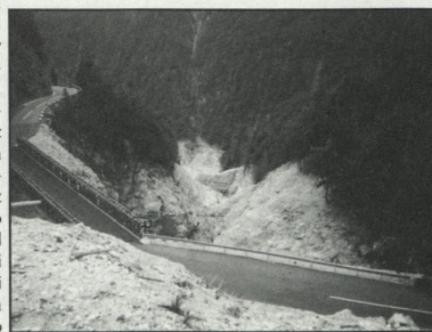
Pogled na del plazišča Stožce v času sanacije
