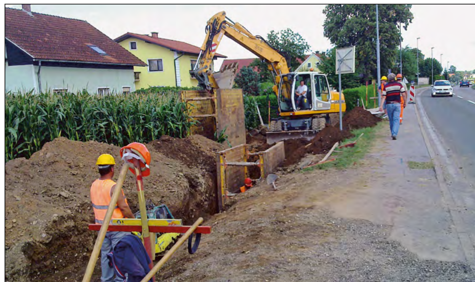
V naselju Zg. Hajdina, »pri Maji«, poteka izgradnja kanala 4.0.
