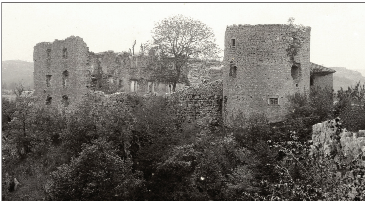
Figure 18: Školj's core, round and square tower from northeastern side, 1909 (CMSA, Trieste, F 003902) Slika 18: Školi z razvalinami grajskega jedra in obema stolpoma iz severovzhodne strani leta 1909 (CMSA, Trieste, F 003902)
