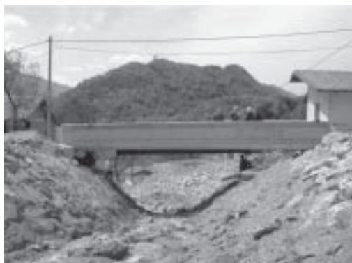
Sl. 8. Razširitev struge in gradnja novega mostu
