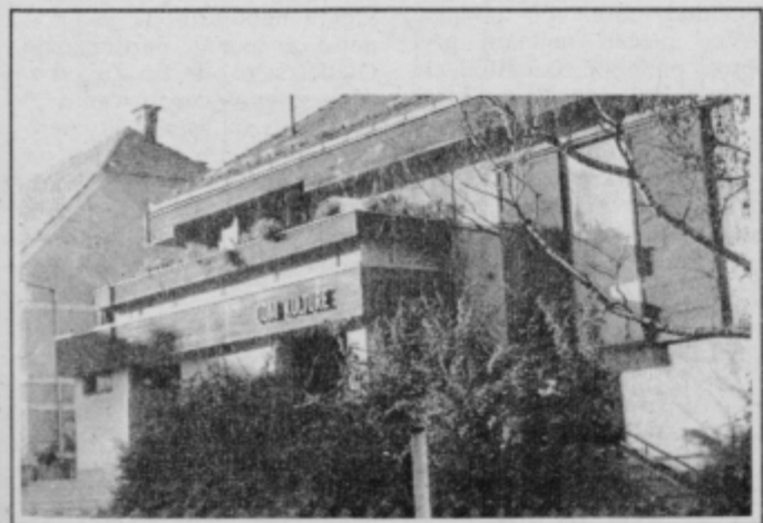
Na zunaj lepa stavba, pa vendar...
