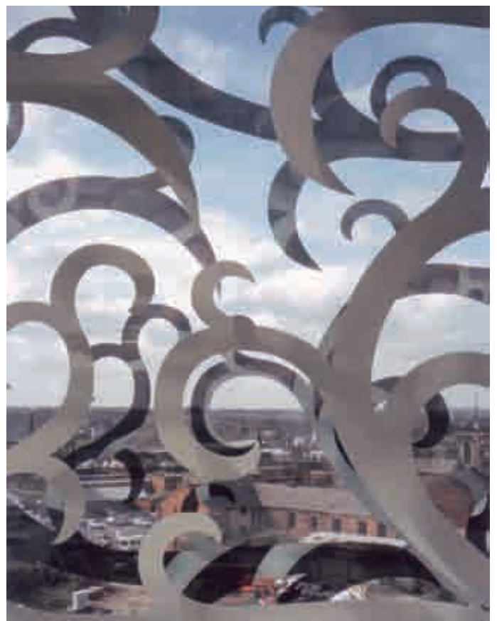
Slika 5: Tehnologija digitalnega tiska keramičnih delcev na steklo omogoča poljubno oblikovanje fasadne površine in zagotavlja trajnost tiskanega vzorca (John Lewis Department Store; Foreign Office Architects, London, 2008) [Pell, 2010: 99].
