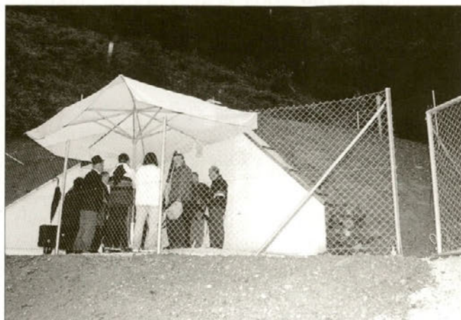
In še pogled na prečrpalnico v Marinji vasi.
