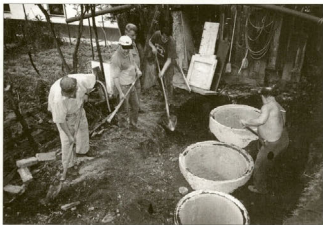
Utrinek iz ene izmed prostovoljnih delovnih akcij – izgradnja tri perkatne pretočne greznice.
