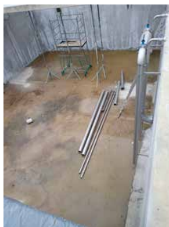
Rekonstruiran bazen, kjer poteka montaža strojne opreme.
