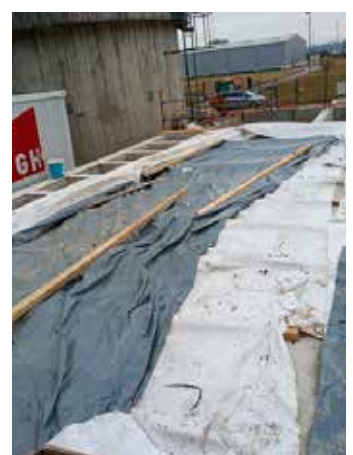
Nadgrajen in rekonstruiran bazen čaka na postavitev zaščitne ograje.
