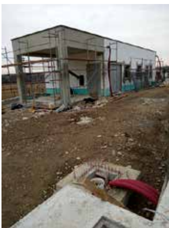
Objekt A je odet v toplotno izolacijo.
