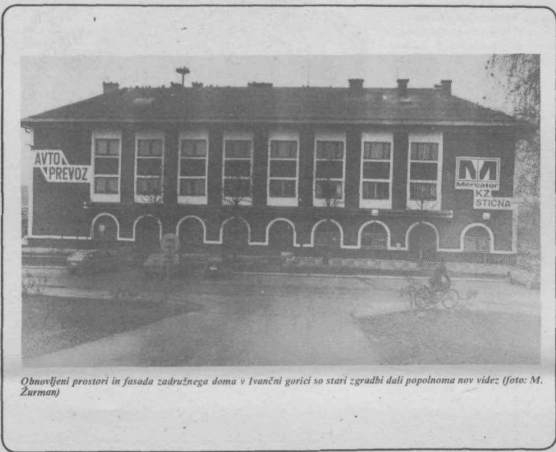
Obnovljeni prostori in fasada združnega doma v Ivančni gorici so stari zgradbi dali popolnoma nov videz (foto: M. Žurman)
