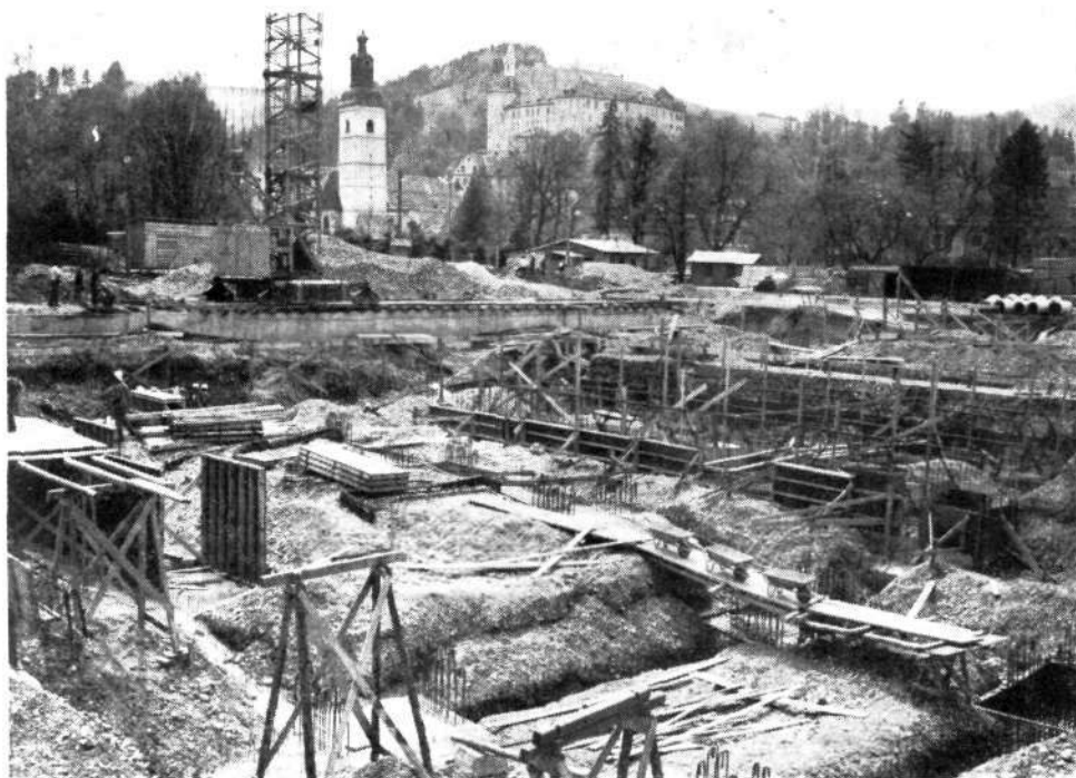
Začetek gradnje Transturistovega hotela v Škofji Loki spomladi 1970
