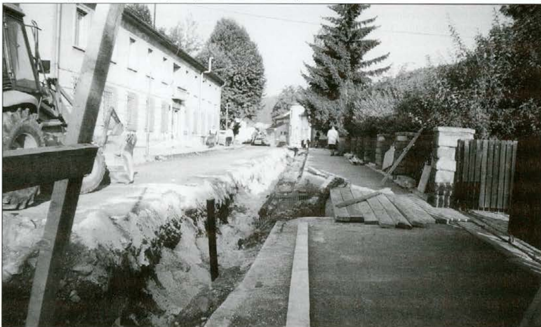
Rekonstrukcija pohorske ceste pri upravni enoti Slovenj Gradec
