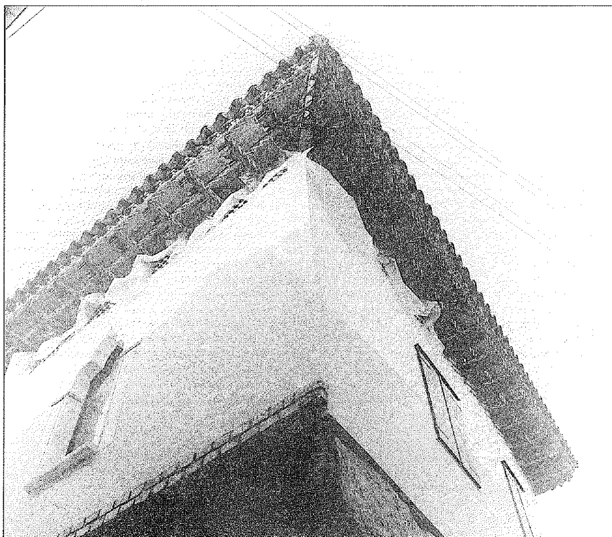
Koper, Obzidna ul. 9 - hiša Favento Guzzi, zunanjsčina po končanih restavratorsko-konservatorskih delih. Po obnovi sedež koprskega oddelka MZVNKD Piran.
