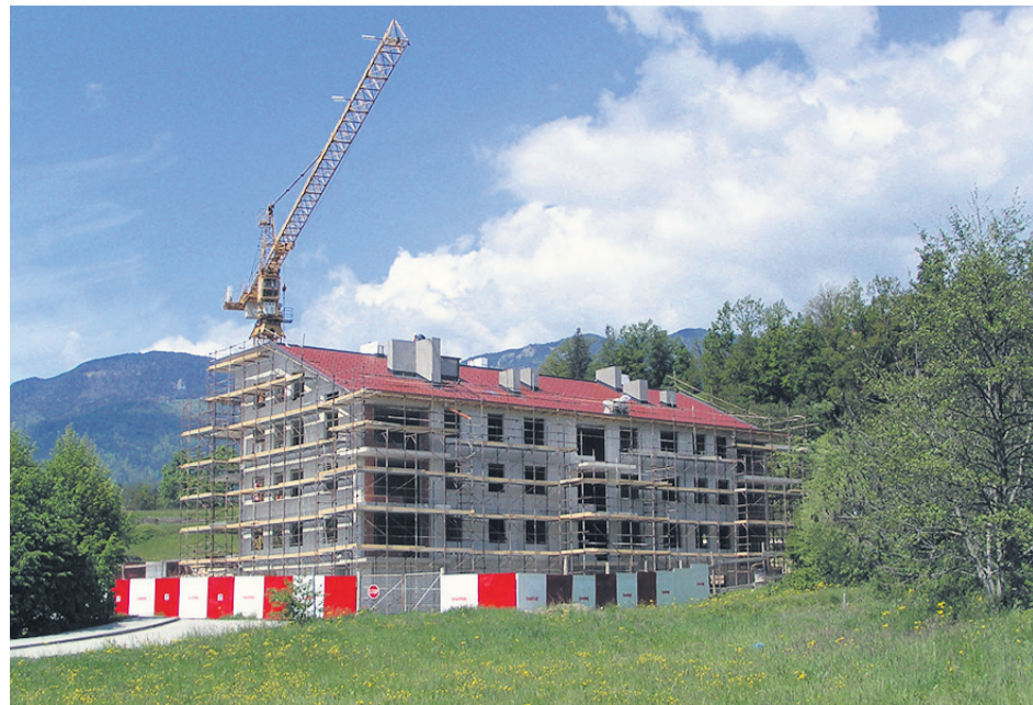
Gradbišče bloka v Podrožniku v Mozirju
