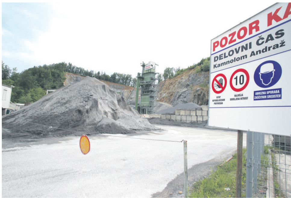
Ena najbolj spornih dejavnosti, ki jo ta čas v kamnolomu Andraž izvaja podjetje Strabag, je proizvodnja asfaltnih mešanic. Krajanji, ki so se pred dnevi udeležili zbora, so z večino zavrnili idejo o nadaljnem obratovanju asfaltne baze, za katero so prepričani, da je na tem območju postavljena nezakonito.
