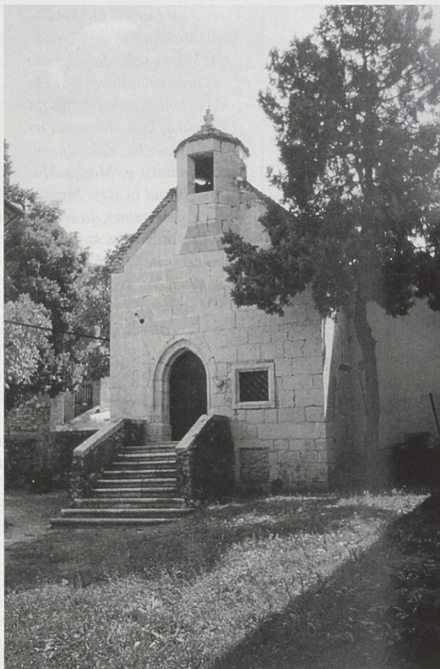
Gotska kapela Marijhe Pomočnice v Lokvi, katere streha je krita s kamnitimi ploščami - skrilji - Fotografija: Agencija Kras
