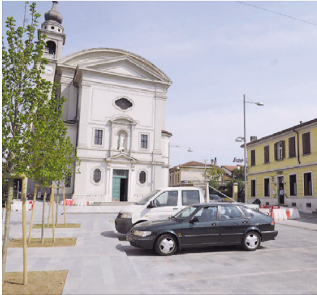
Obnovljeni štandreški trg
