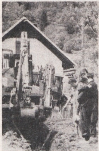
ZAMENJUJEJO VODOVODNE CEVI - V Kopoljah v občini Dobrepolje javno komunalno podjetje Grosuplje zamenjuje dotrajane vodovodne cevi (na fotografiji).
