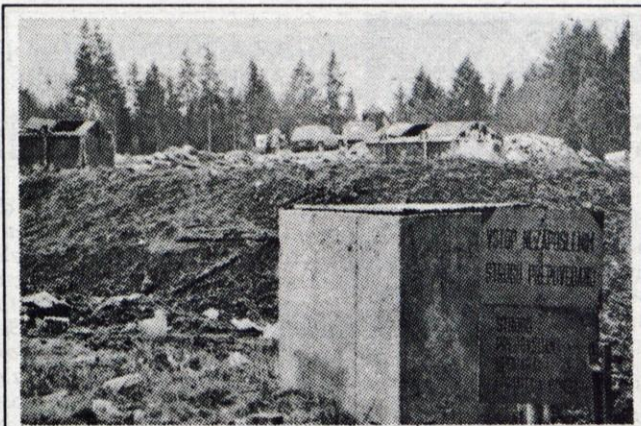
Zaenkrat je dostop na odlagališče odprt, kontrolorja pa ni vedno tam. • Foto: S. Saje
