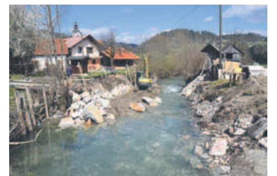
Sanacijska dela na strugi Gradaščice.
