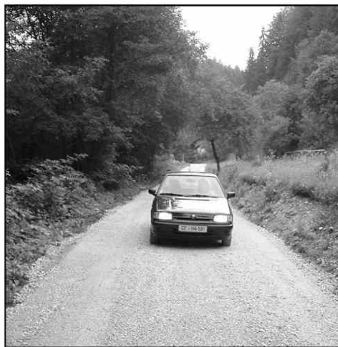
Urejanje ceste v zaselku Strmina
