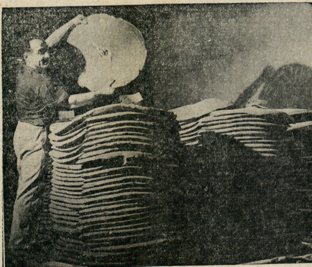
VELIKANSKE OMLETE? — Na sliki vidimo delavca, ki sklada velike porcelanaste "omlete", ki jih bodo v posebnih modelih stisnili v električne izolatorje.
