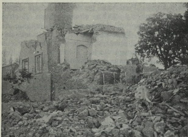
Sl. 15. Enonadstropna hiša v Kakhku
