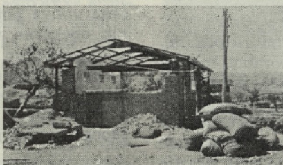
Sl. 17. Elektrogeneratorska postaja v Kakhku
