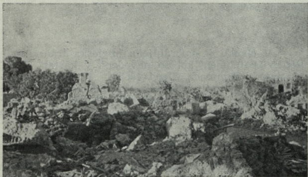
Sl. 3. Center Kakhka po potresu
