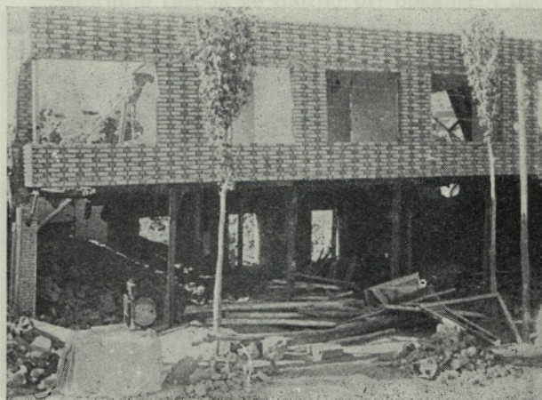
Sl. 19. Stavba banke v Kakhku v gradnji
