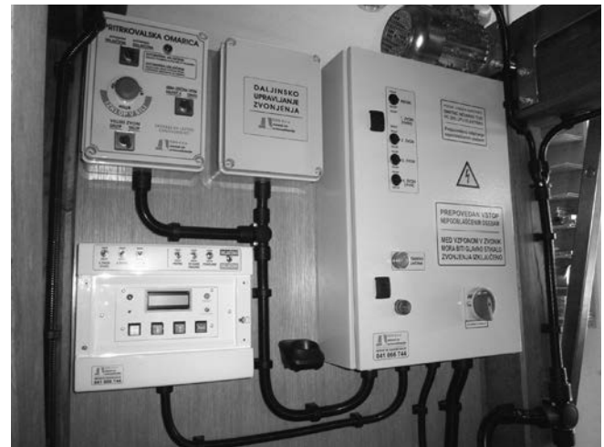
Oprema za programsko vodenje zvonjenja zvonov. Foto: Tomaž Klopčič, 22. 4. 2015.
