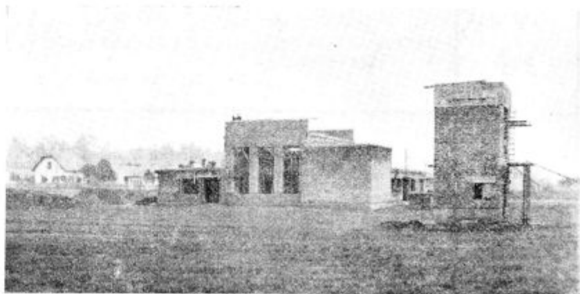
Novo radijsko poslopje na Teznem pri Mariboru. Zgradba na desni je namenjena za električni transformator.
