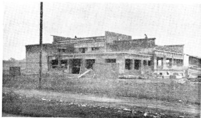
Pogled na novo zgrajeno poslopje radijske oddajne postaje na Teznem pri Mariboru.
