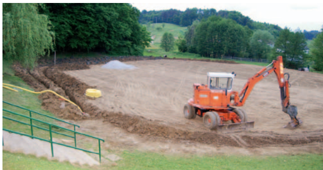
Polaganje cevi na igrišču (foto: Andrej Vrtič)
