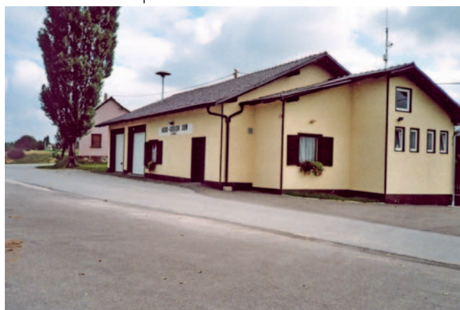
Nova streha na gasilskem domu Vidonci
