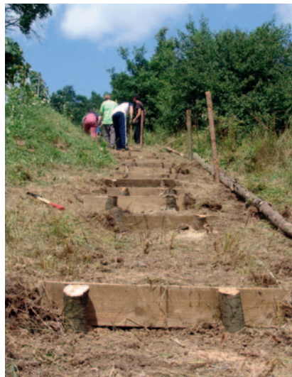
Izgradnja stopnic na strmini poti
