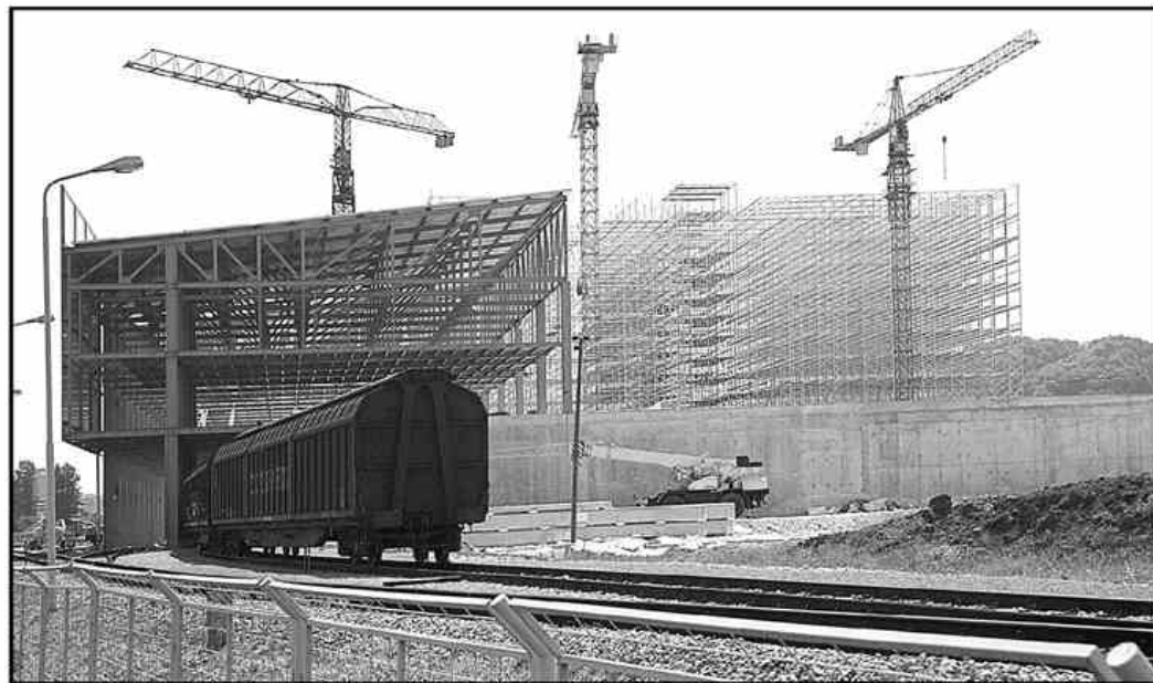
Gradnja skladišča Gorenja – v nebo se že vzpenjajo visokoregalne konstrukcije
