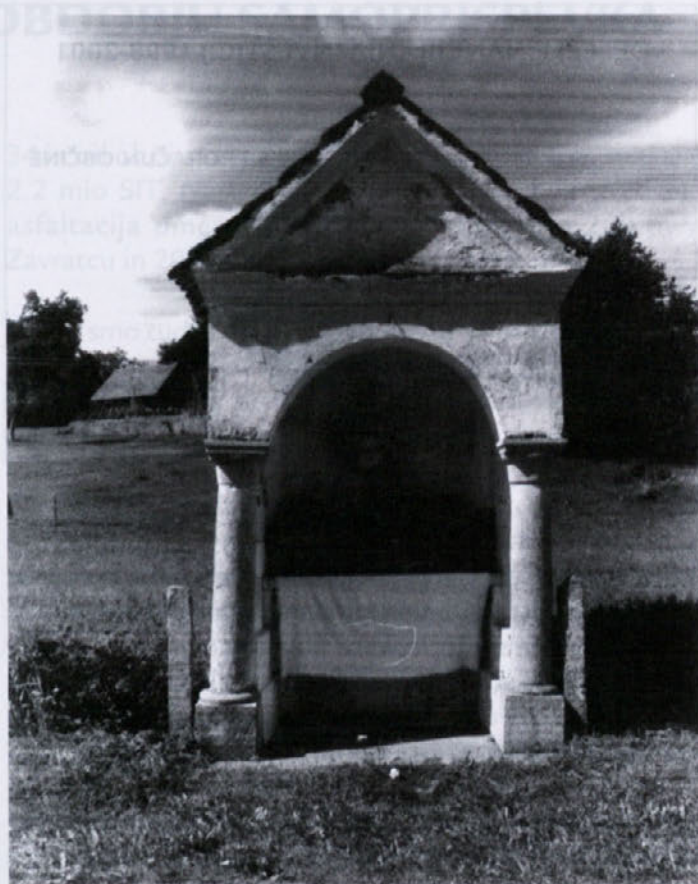
Kapela pred obnovo.
