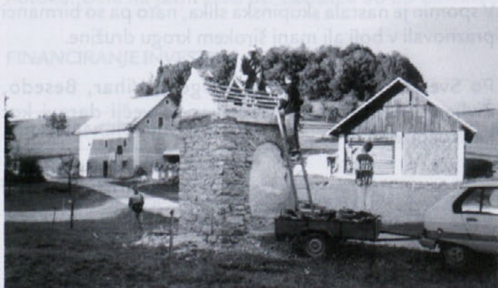
Med potekom obnovitvenih del.
